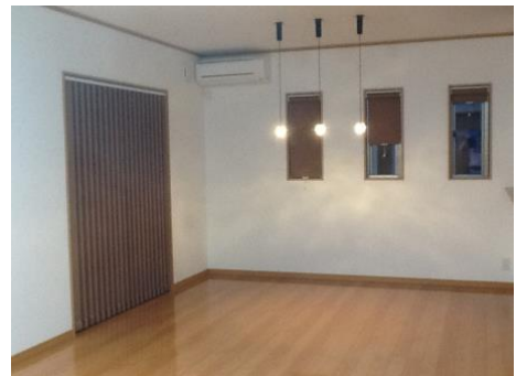
＜自社施工のブラインド工事完工写真＞
