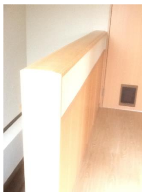
＜施工後＞ (手摺ダイノックシート貼り工事)
