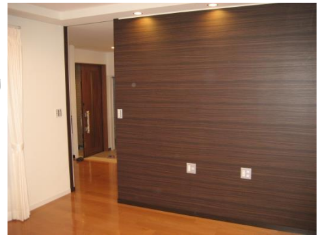
＜自社施工の床・クロス貼りの完工写真＞ （木目模様のクロスと白色系クロス）
