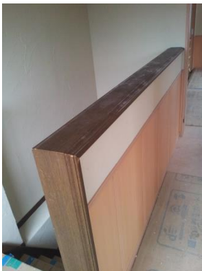
＜施工前＞ (手摺ダイノックシート貼り工事)
