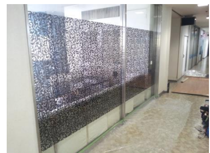
＜施工後＞ (窓ガラスフィルム貼り工事)
