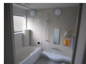
＜浴室・洗面の更新＞
