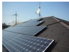
＜太陽光パネル設置＞
