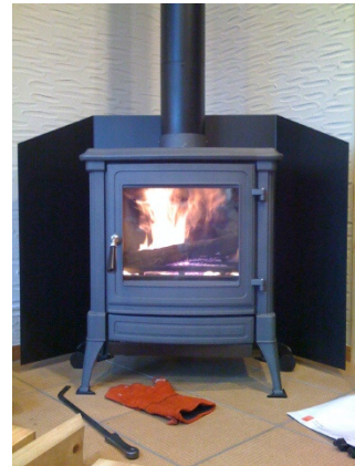
“そよかぜの家”の施工例
