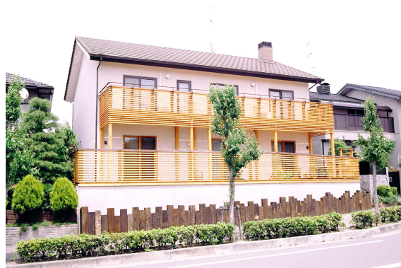
そよかぜの家の施工例
