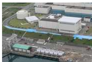
【原子力発電所】
