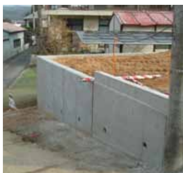
土留め壁（擁壁）施工
