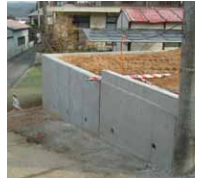
土留め壁（擁壁）施工
