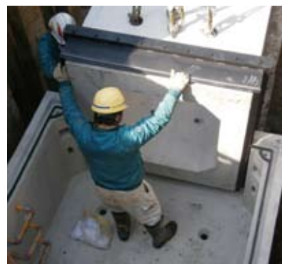
BOXラウンドプレス 1辺1000mmの角タイプ 施工例:愛知県岡崎市
