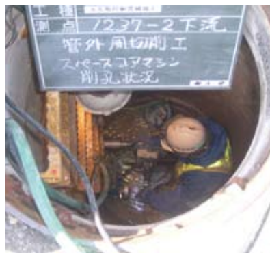
ゴライアス工法 塩ビ管直径200mm 施工例:静岡県吉田町
