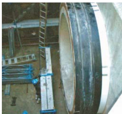
スぺーサジョイントDR 超大口径(4020mm) 施工例:大阪府枚方市
